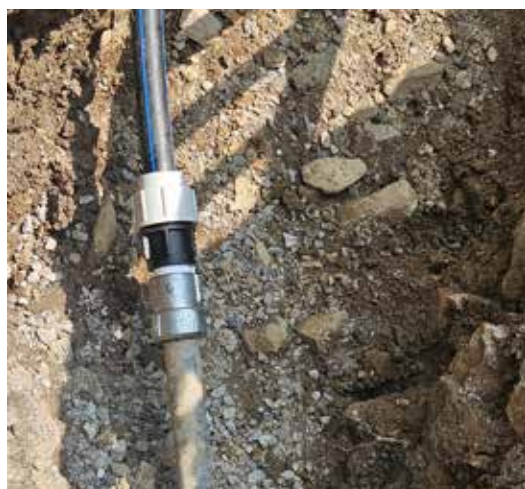
Particolare connessione fra nuova e vecchia tubazione
