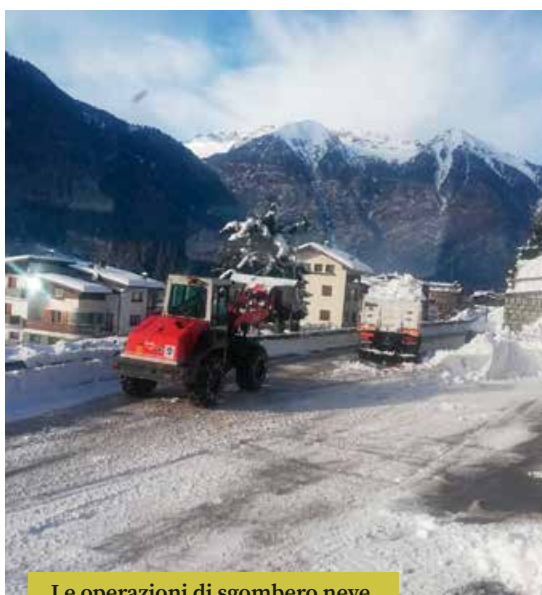
Le operazioni di sgombero neve
