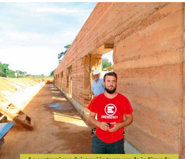
La costruzione dei muri in terra cruda in Uganda
