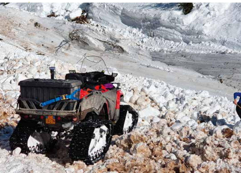
Intervento su valanga in loc. Rilon per consentire accesso ai mezzi di soccorso
