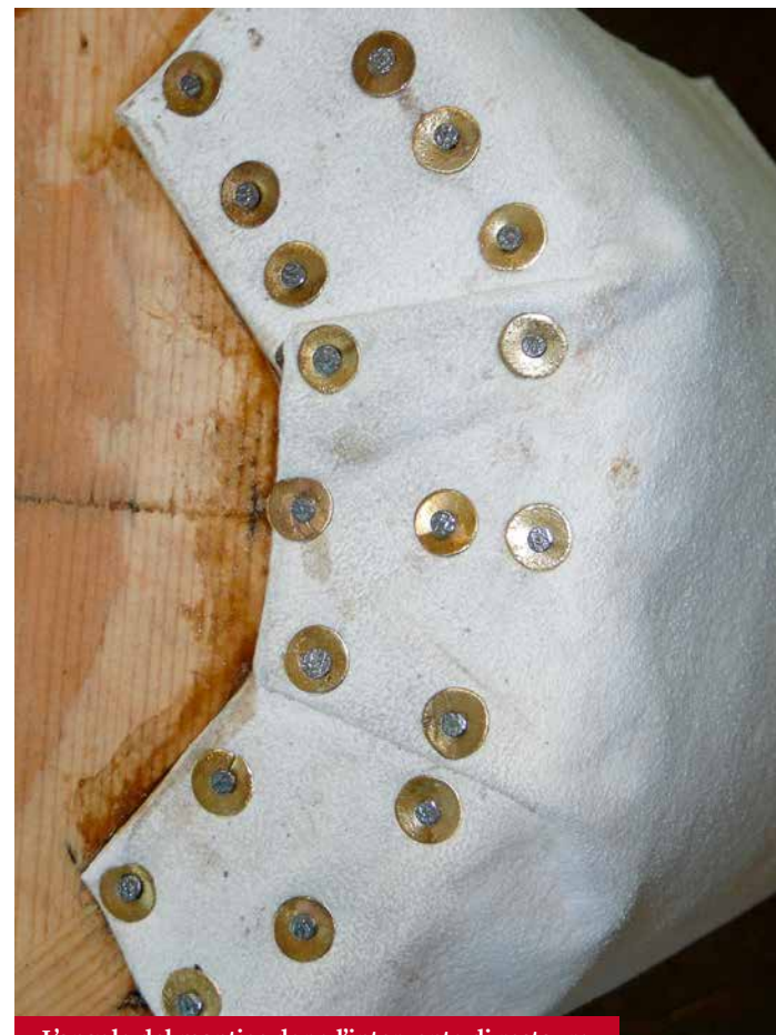
L'angolo del mantice dopo l'intervento di restauro
