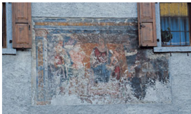
Prima del restauro.
