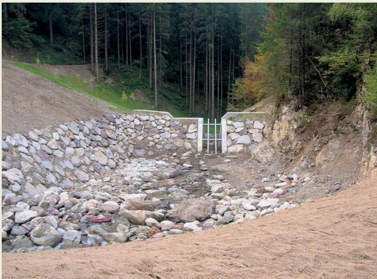
La briglia "filtrante" ultimata nella primavera 2009: questo intervento nasce dalla necessità di trattenere la parte più grossolana dei detriti trasportati dalle piene del Flanginec, impedendo che gli stessi si riversino sul conoide sottostante (foto Antonino Torrisi).
