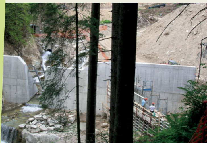
Operai del Servizio Bacini montani impegnati nell'autunno del 2008 nella realizzazione della briglia "filtrante" al Marucac' (foto Lorenzo Malpaga).
