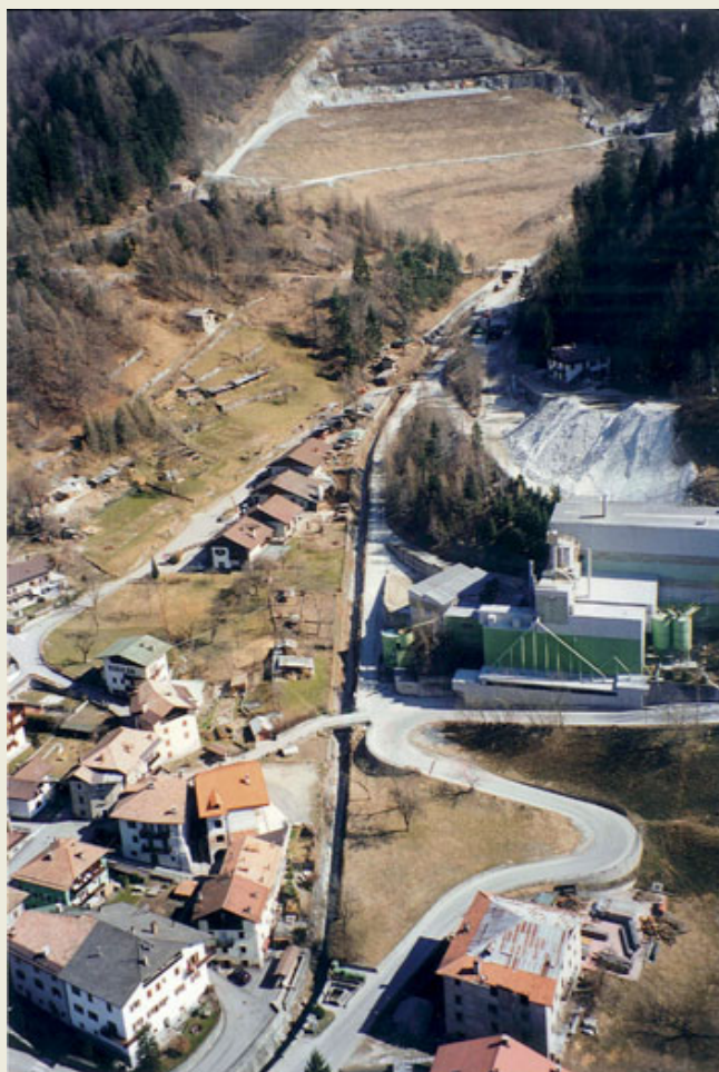
Veduta aerea sul Flanginec, il 18 aprile 2000. Quell'anno segnò il raggiungimento della quota minima di 770 metri prevista per lo scavo all'interno della “Cava Massimeno”. L'attività estrattiva cessò definitivamente il 31 dicembre del 2004 (foto Lorenzo Malpaga).
