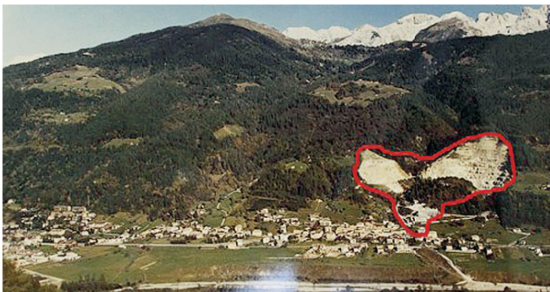
Scorcio panoramico dell'area in oggetto prima della bonifica.
