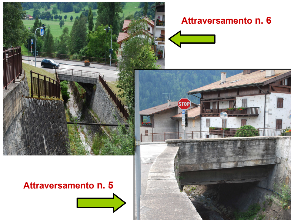
Figura 17 - Attraversamenti da presidiare sul rio Flanginech .
