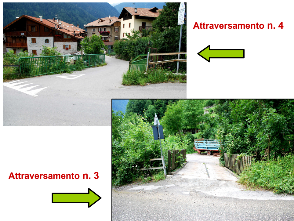
Figura 16 - Attraversamenti da presidiare sul rio Flanginech .
