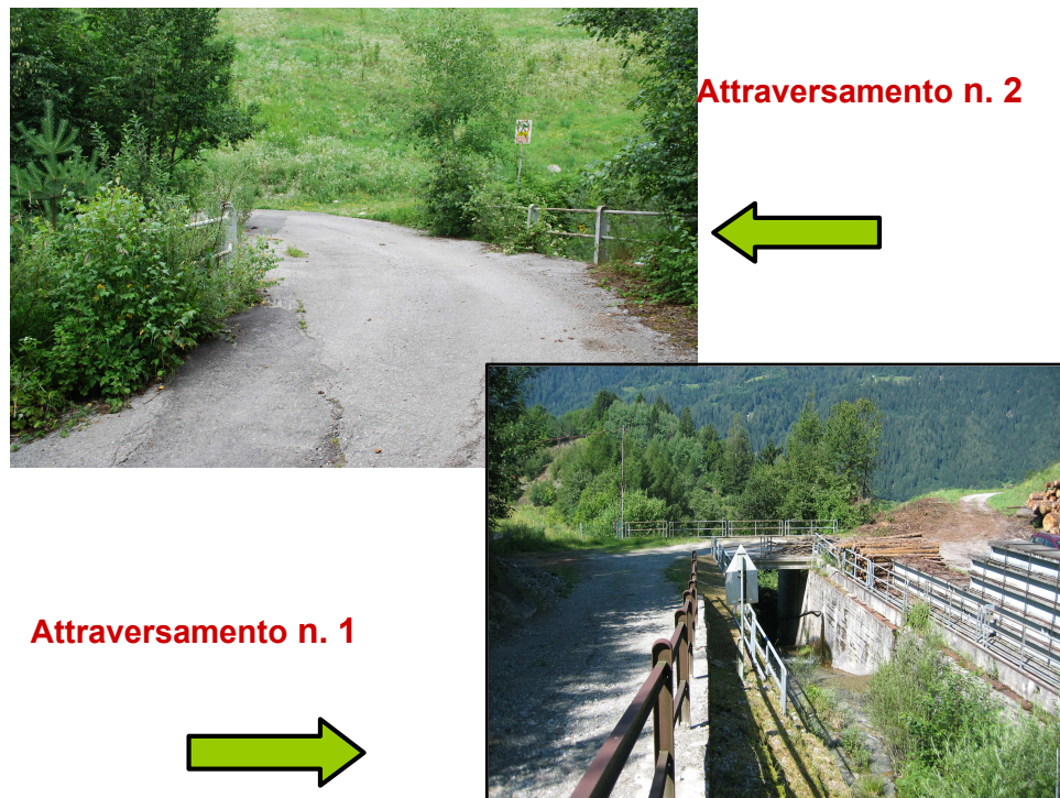
Figura 15 - Attraversamenti da presidiare sul rio Flanginech.
